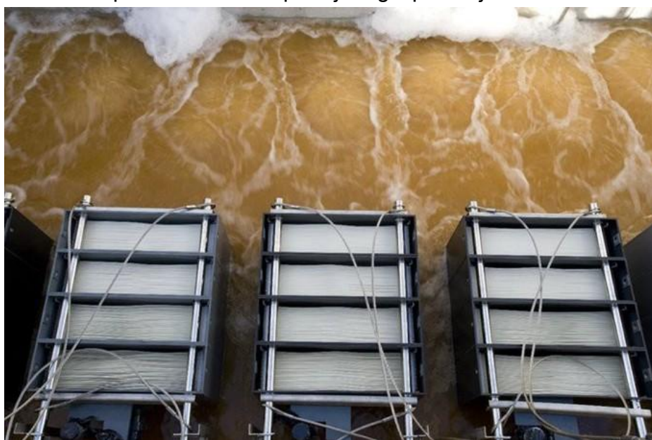
Slika 29. Izgled potopljenih membranskih modula ultrafiltracije unutar MBR reaktora
