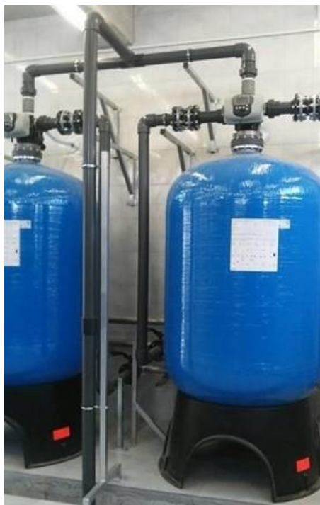
Slika 16. Šematski prikaz trosistemskog (tripleks) postrojenja za omekšavanje tehnološke vode
