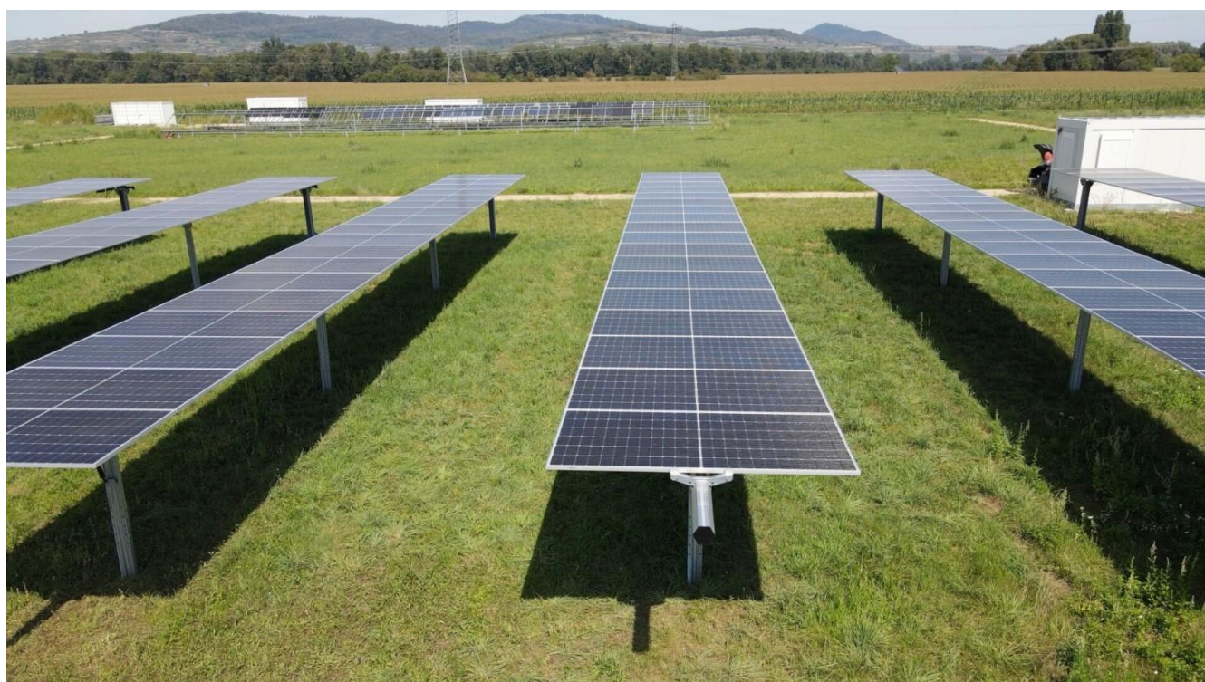
Илустрација 10 - пример фотонапонских панела постављених на конструкцију са једноосним праћењем
